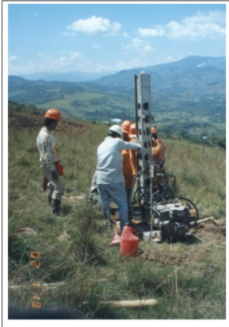
**Foto 20:** Equipo de perforación usado para el pozo de prueba No. 4. (Taladro Balco)
