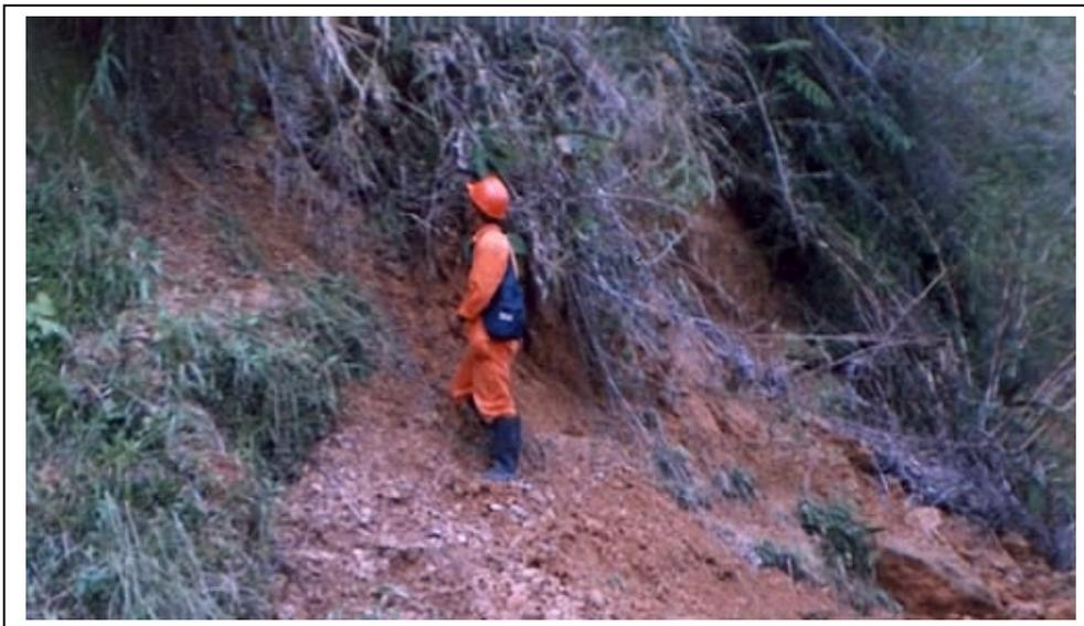
**Foto 4:** Proceso erosivo asociado al corte de la vía en la zona de prueba No. 1
